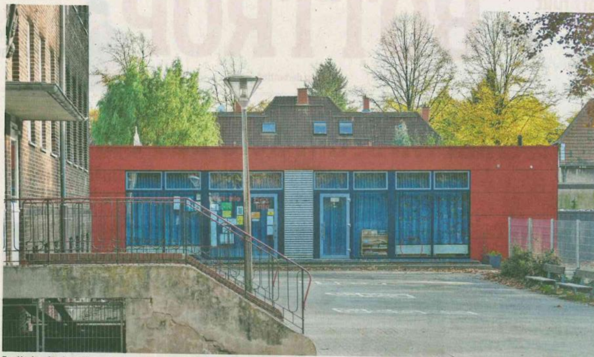
Der Neubau für den Offenen Ganztag wird an den bisher genutzten Pavillon gesetzt. Ein Durchbruch verbindet dann die beiden Gebäude.
